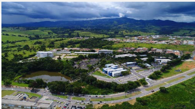
Foto 1. Vista da UNIFEOB – Campus Mantiqueira.
