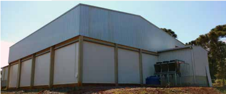
Foto 2. Câmara Frigorífica para Batatas (vista externa)
