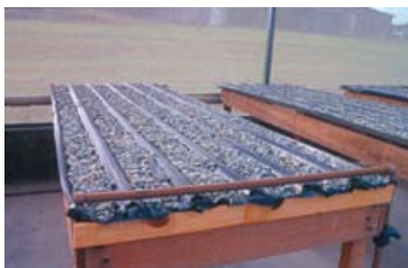
Telha de fibrocimento com brita
