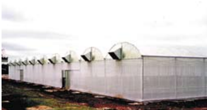
Vista externa dos telados na Unidade de Produção de Material Básico de Batata Semente da Cooperativa Agrícola de Cotia em Canoinhas (SC)
