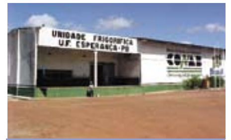
Unidade de frigorificação de batata-semente em Esperança (PB), com capacidade de 700 t
